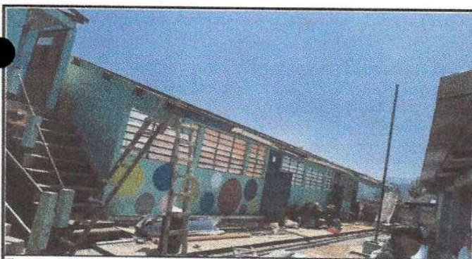
Foto 5: Colocacion de lamina en aula 5 y 6 y Direccion
