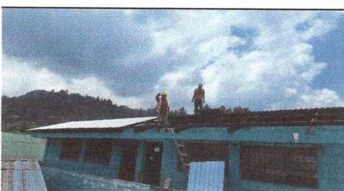
Foto 4: Colocacion de costanera y lamina aula 3 y 4
