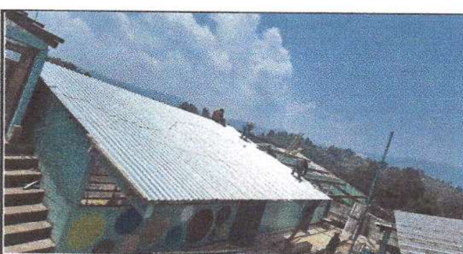
Foto 6: Colocacion de lamina en aula 5 y 6 y direccion
