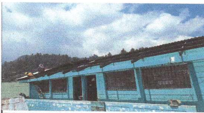
Foto 3: Colocacion de costaneras aulas 1 y 2
